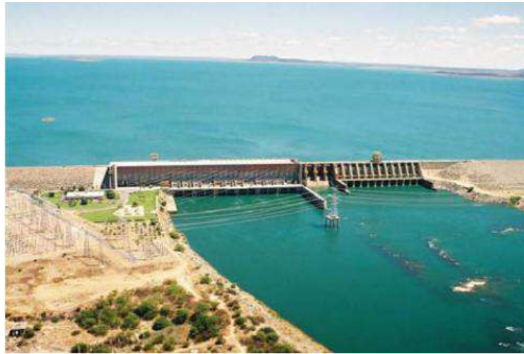
Foto 1: Casa de força e vertedouro da UHE de Sobradinho.
